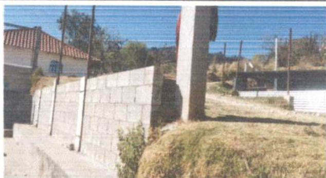
Foto 3: Parte de debajo de la reparación del muro perimetral del establecimiento.
