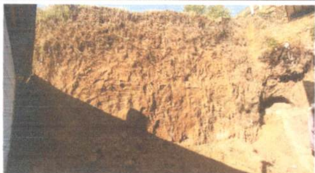
Foto 1: Inicio de trabajo de muro de contención, parte de atrás de la cocina escolar.
