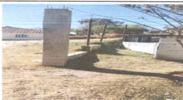
Foto 5: Construcción de columnas, en la entrada principal del establecimiento.
