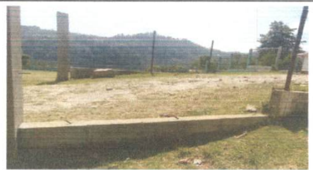
Foto 4: Parte de arriba, del muro perimetral del Centro Educativo.
