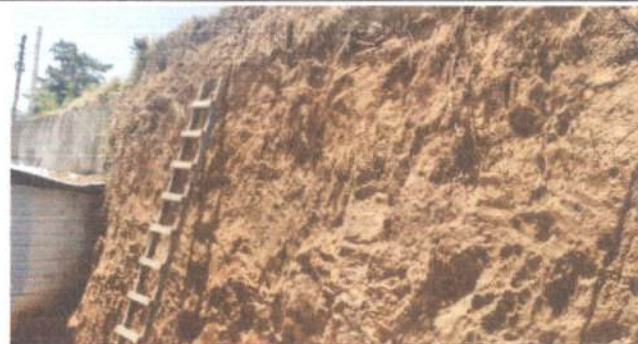
Foto 2: Preparación del espacio de muro de contención, parte de atrás de la cocina escolar.
