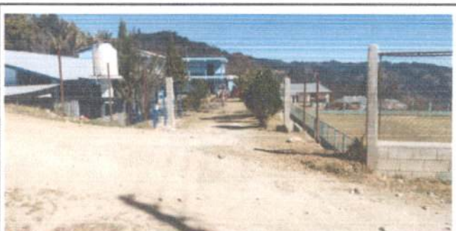
Foto 6: Espacio entre columnas donde se colocará el portón de metal, siendo la entrada principal.
